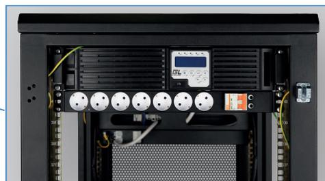
На фронтальной стороне шкафа находится лицевая панель ИБП, на ней расположен LCD-экран, кнопки управления ИБП и 1 блок электрических розеток с автоматом на 25А.
